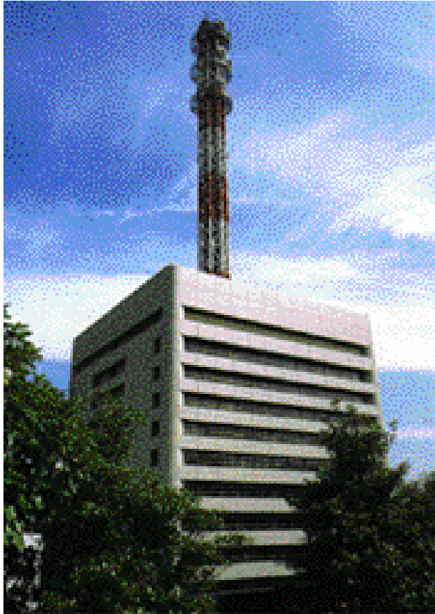
J-Power Building (Ginza, Tokyo)
